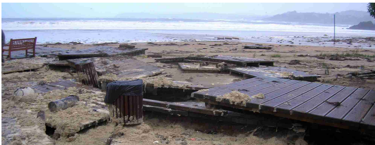
■ Estado que presentaba o paseo de Bastiagueiro despois do temporal
