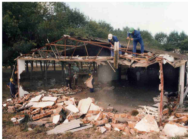
■ Demolición e recuperación pública
