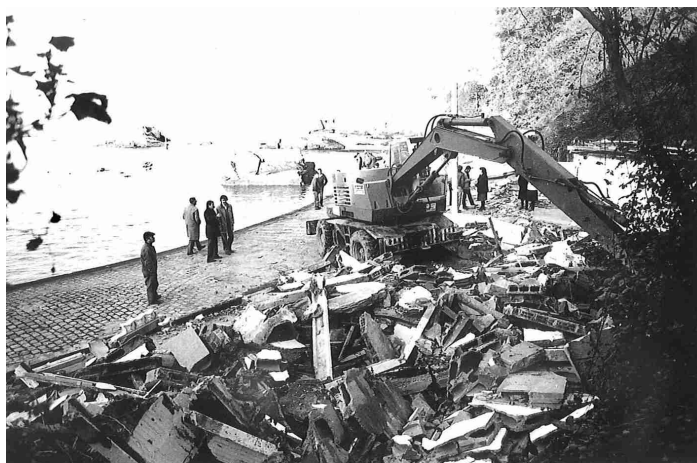
■ Demolición das casetas e recuperación do espazo público
