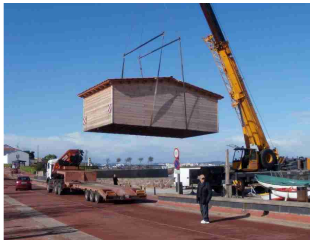
■ Retirada da caseta no porto de Mera
