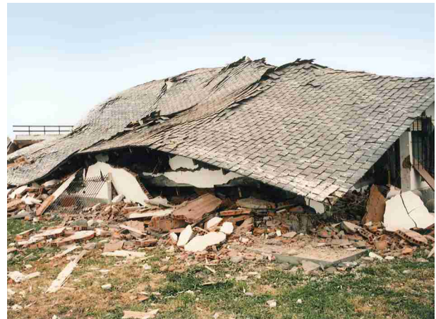
■ Demolición do edificio da illa do Portelo
