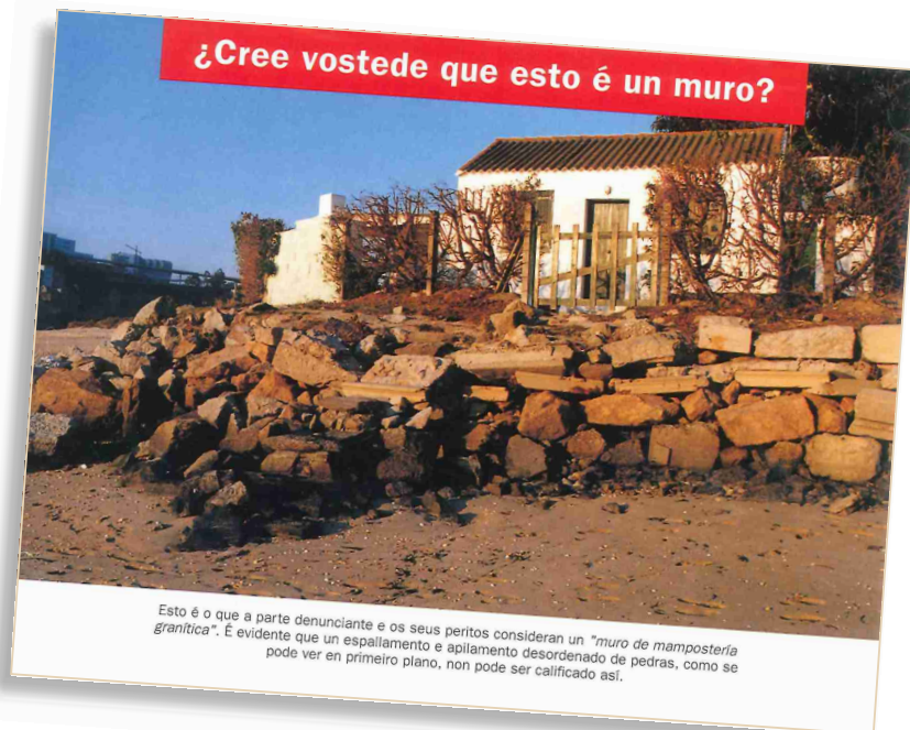
■ “Muro de cachotería” polo que García Seoane foi inhabilitado
