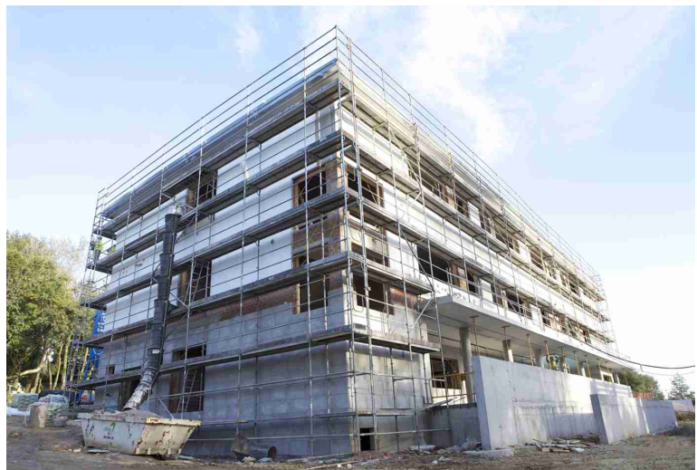
■ Construción do novo colexio en Nós
