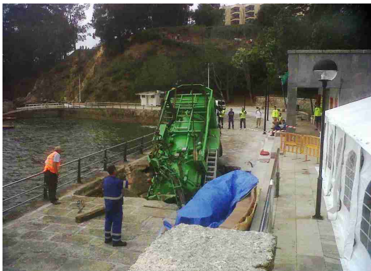
■ Afundimento no porto de Santa Cruz
