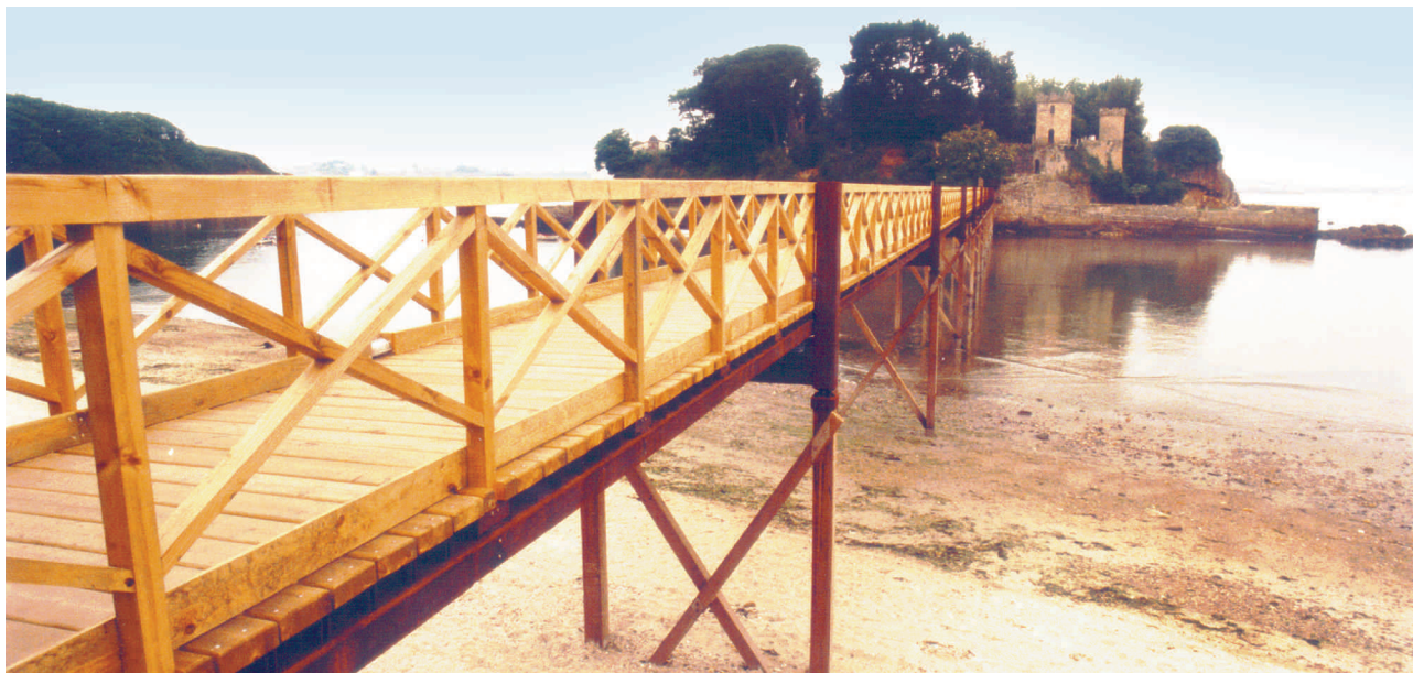
■ Dotación de pasarela do castelo de Santa Cruz
