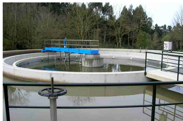
■ Depuradora de Oleiros
