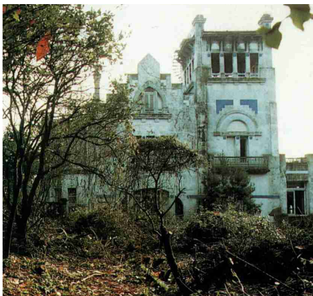
■ Estado ruinoso no que quedou Rialeda despois do incendio
