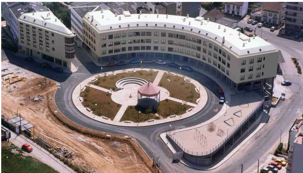
■ Vista da construción da praza de Liáns
