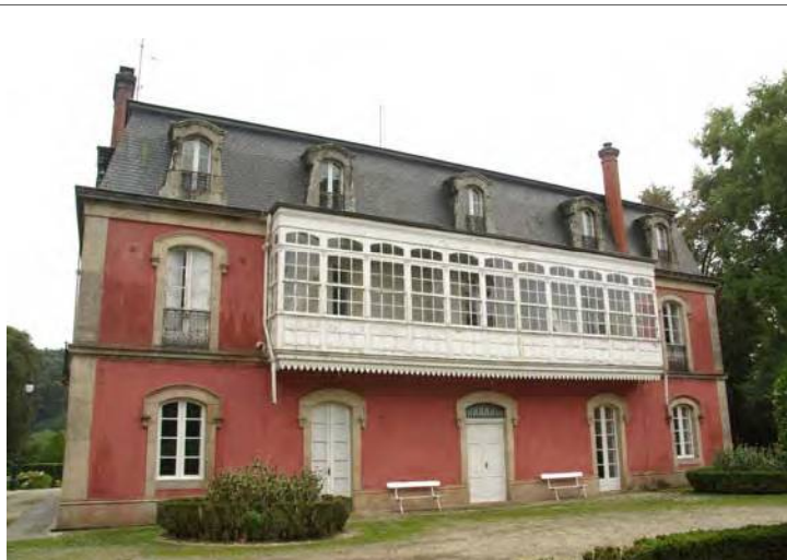
Foto 4. Fachada norte coa galería de madeira.
