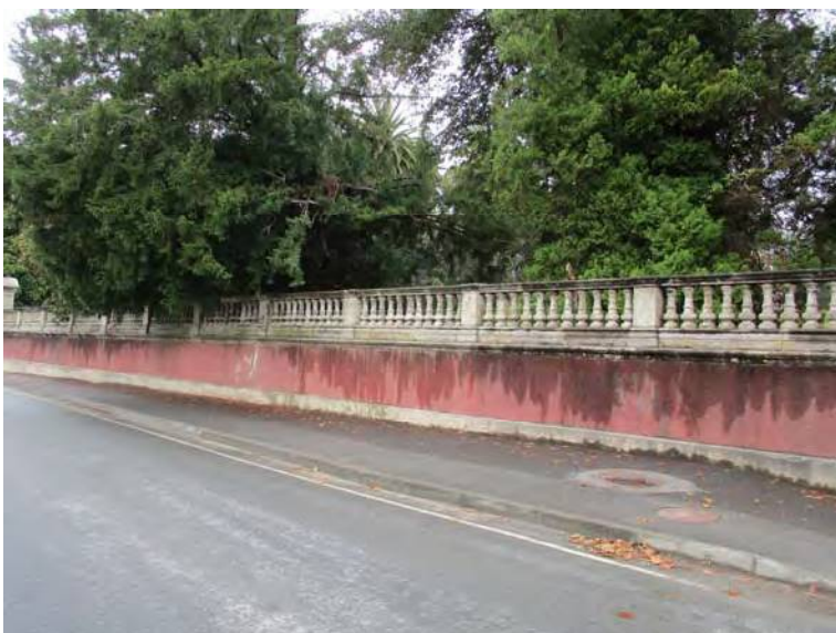
11. Treito oriental do muro sur (principal).
