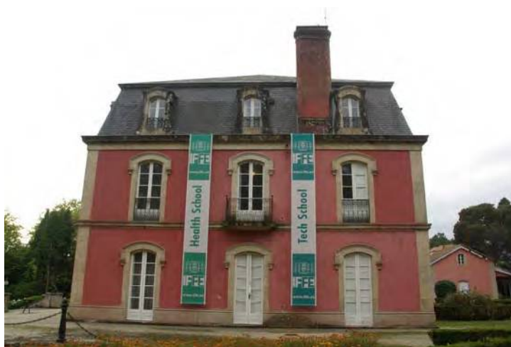
Fotos 1-2-3. De arriba a abaixo: fachadas sur (principal), oeste e leste.
