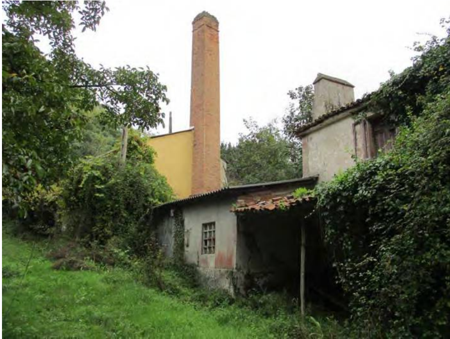
1. Vista xeral da construción desde o suroeste.
