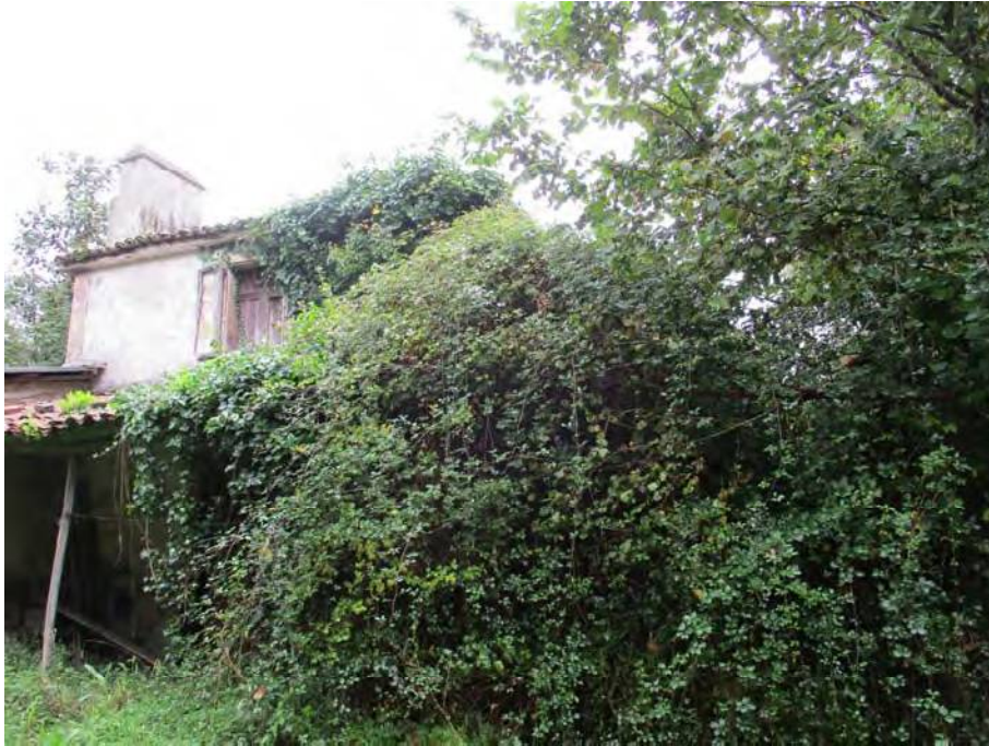
1. Vista xeral da construción desde o suroeste.
