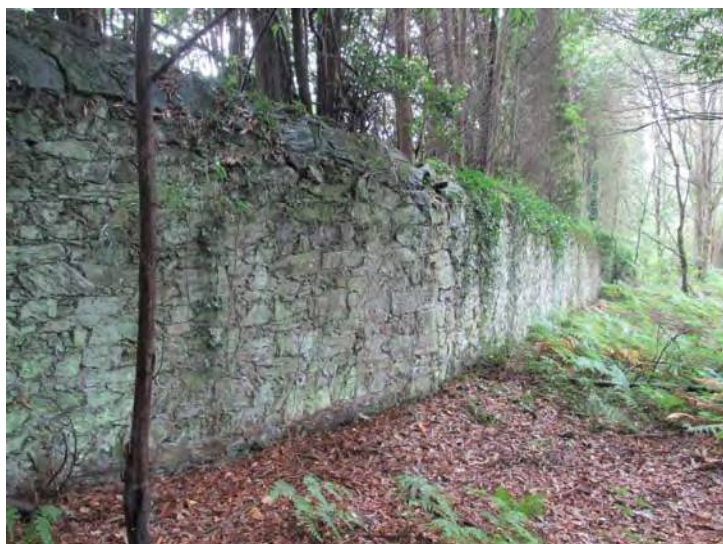
20. Treito do muro oeste (exterior).
