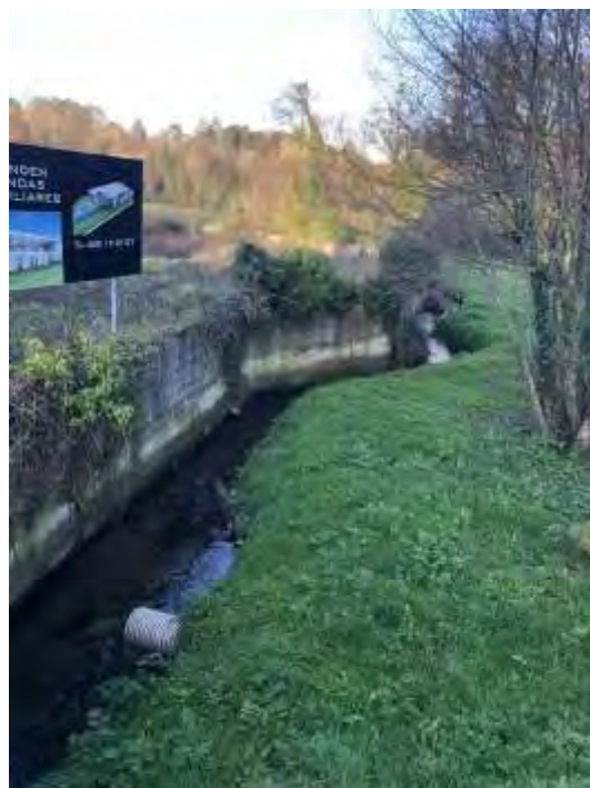
Foto 30. Tubo vertido augas pluviais
