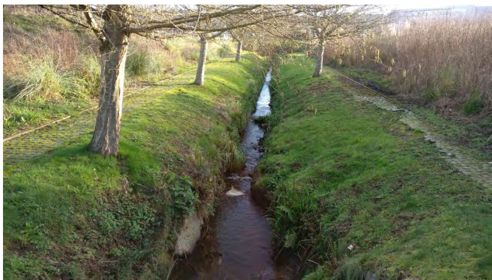
Obra executada de canalización do rego da Cova.
