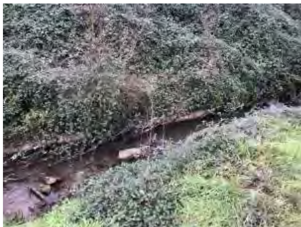
Foto 58. Aspecto do rego no tramo final
