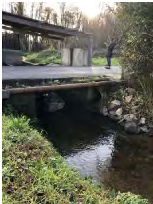
Foto 37. Paso baixo estrada
