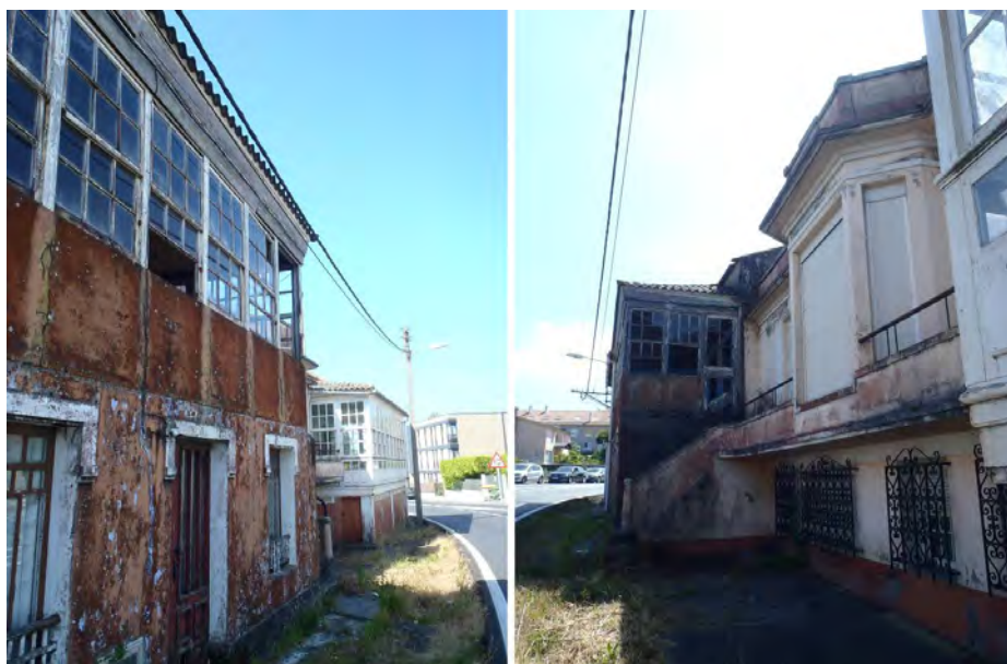
Fuente: Propia. Vista del Elemento B65 desde la carretera DP-5813. Se comprueba que en este tramo urbano el viario carece de acera.
