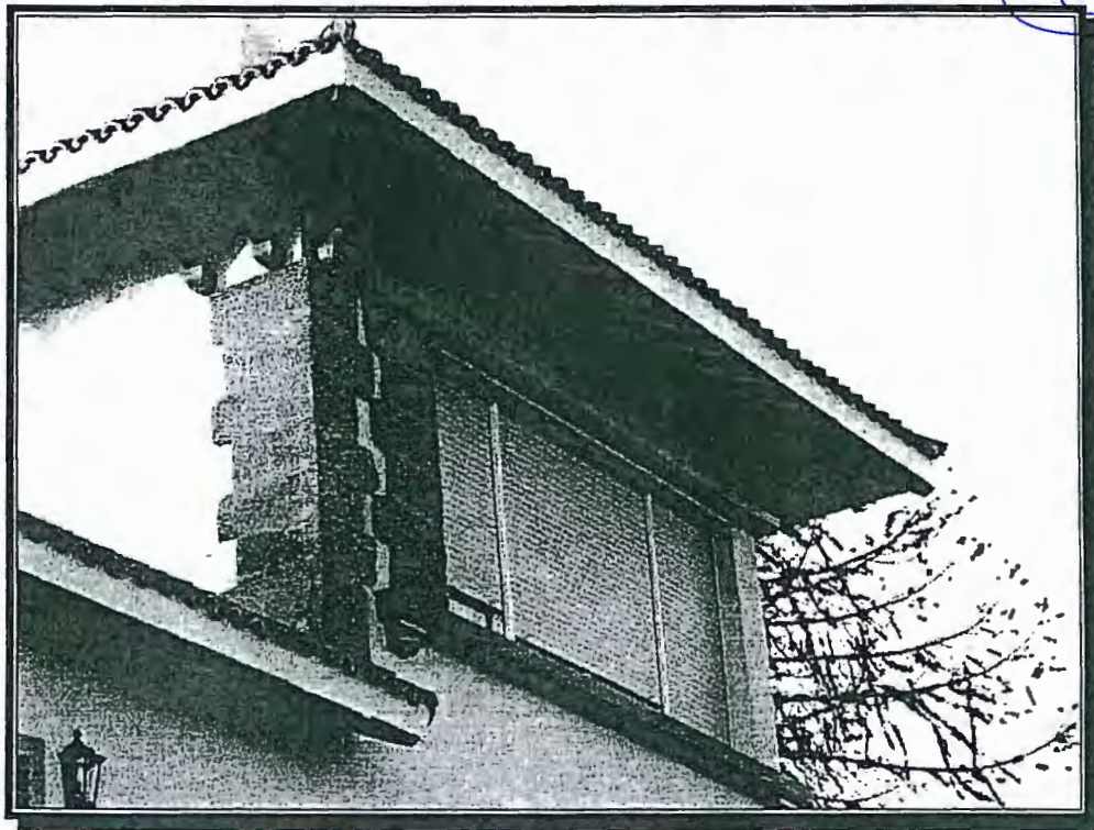
Fachada sur (detalle de mirador y aleros)
