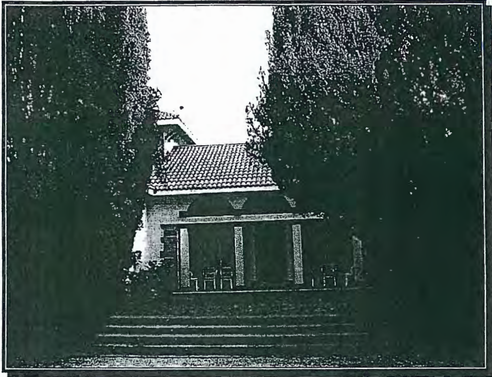
Fachada norte, acceso escalinata (piso alto de la edificación)
