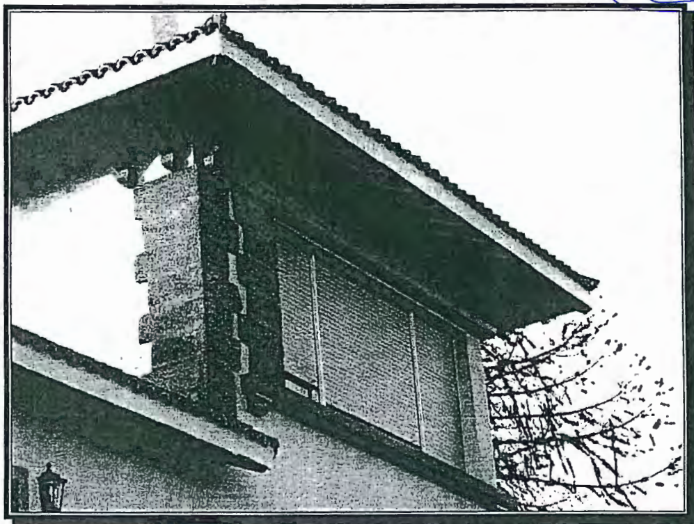
Fachada sur (detalle de mirador y aleros)
