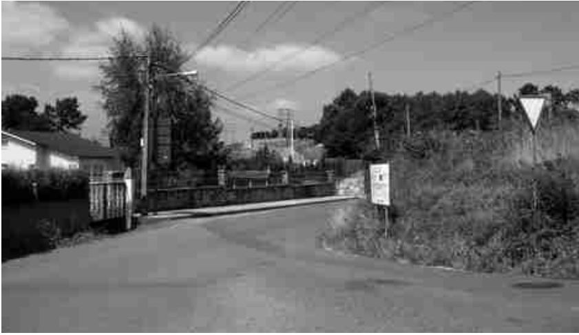
■ Aspecto da rúa A Seara antes da obra
