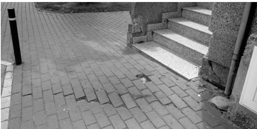
▼ O afundimento do edificio está a provocar o levantamento das beirarrúas anexas
