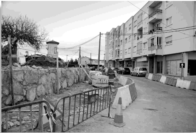
■ Obras de retranqueo na rúa Celso Emilio Ferreiro
