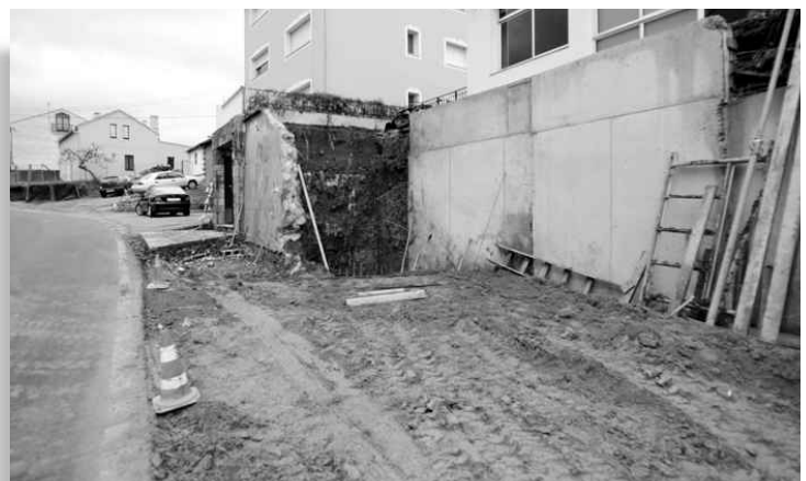
■ Situación actual coa execución
