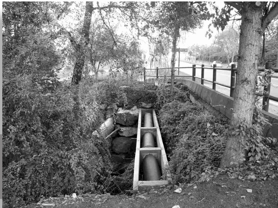
■ Colector de fecais de nova impulsión en Bastiagueiro
