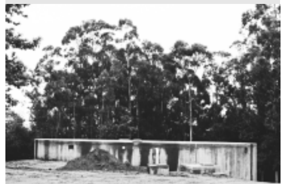
O novo depósito da Edreira
