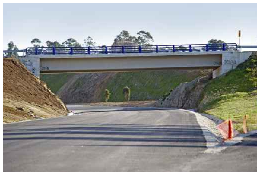
■ Os pasos elevados están deseñados para que o tránsito local non interceda cos vehículos que circulan pola Ártabra
