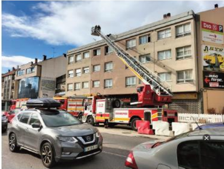
Los bomberos emplearon una autoescalera para acceder a la cubierta | Pedro Puig
