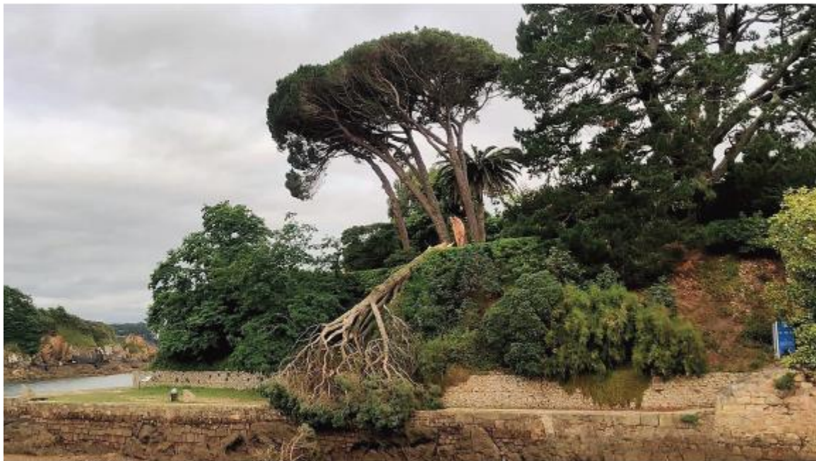
Árbol que se partió sobre el muro del castillo de Santa Cruz
