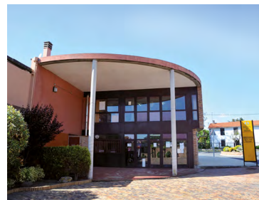
BIBLIOTECA PÚBLICA MUNICIPAL Mª JOSÉ TRINCADO A Lagoa (Urbanización Pía de Maianca). R/ Curros Enríquez, nº44 15177 MERA
