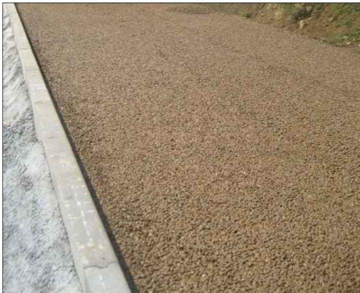
Pavimento drenante para tránsito peatonal mediante sistema "Pavipor" o similar con áridos sobre rejilla alveolar.
