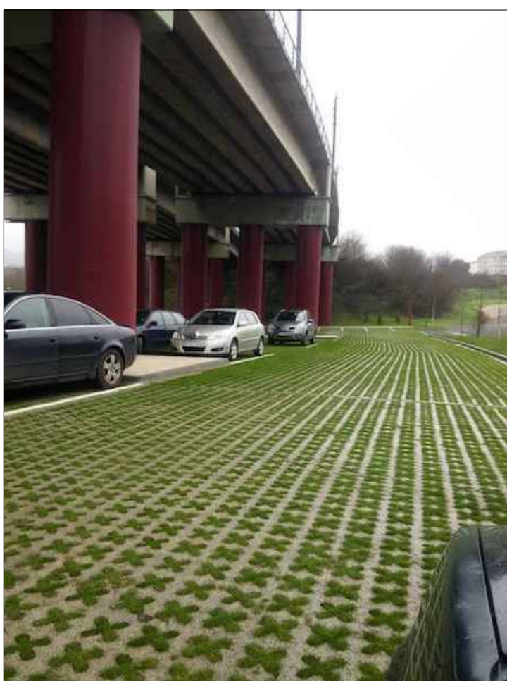
Pavimento drenante mediante sistema "Césped armado" tipo Paviprint o similar para zonas de tránsito vehicular en área de aparcamiento
