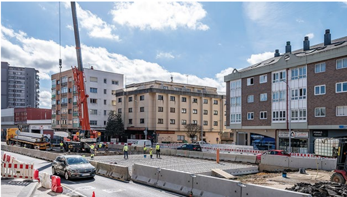
■ Neste momento a obra atópase na parte final da súa execución, coa escavación do túnel. De non xurdir ningún imprevisto, debería estar finalizada no outono.
